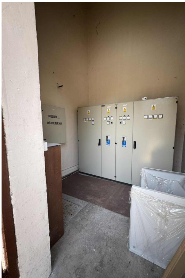
Figura 4 Pomieszczenie techniczne z miejscem wpięcia PV
